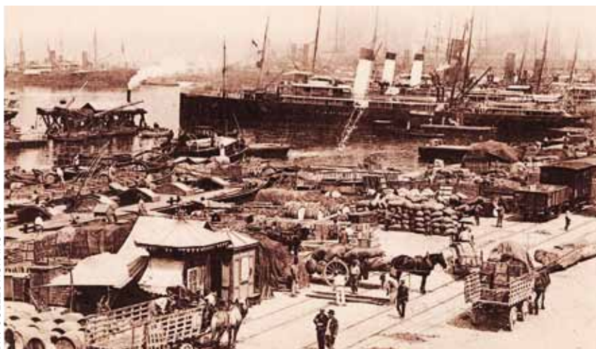
Marseille, quai de la Joliette, 1910-1930.
